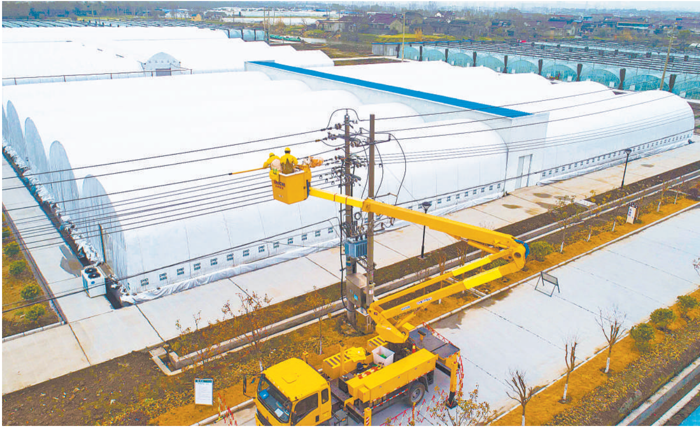
1月24日,电力工人在江苏省泰州市姜堰区三水街道桥头香菇产业园区对新建电气化恒温恒湿香菇育苗大棚进行作业。近年来,泰州市姜堰区三水街道推广农机化、电气化,种植无公害香菇1500多亩,并建起100亩国家食用菌标准化生产示范基地,带动4000多名农民工就业创收。同时开展香菇深加工,生产可直接食用的香菇脆片等食品,每亩实现纯收益2万元以上,香菇产业年总产值达1.1亿元。 汤德宏摄(中经视觉)
