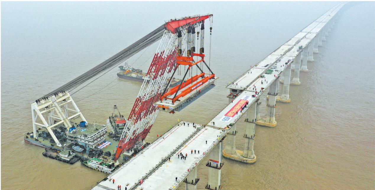
1月24日，随着一片重达1800余吨的70米预制箱梁放置到位，舟岱大桥顺利实现主线贯通。舟岱大桥是宁波舟山港主通道项目的主要组成部分，全长约28公里，按双向四车道高速公路标准设计，建成后将与甬舟高速相连。
