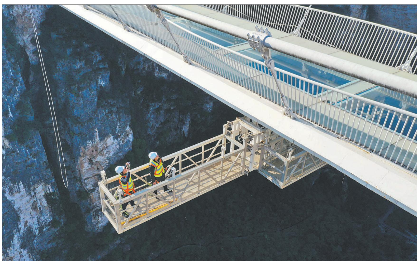
▲1月19日，湖南省张家界大峡谷景区玻璃桥巡检员对玻璃桥主缆索夹、桥梁焊缝等重点部位进行检查，排隐患，保安全。
