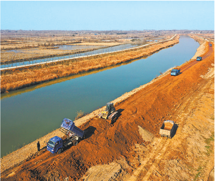
1月18日,安徽省全椒县如意河左岸,工程车辆在加固堤防。入冬以来,该县加强农田水利建设,加快健全农业灌溉设施体系、补齐防汛抗旱设施短板,为春耕备耕和防汛抗旱夯实基础。沈 果摄(中经视觉)
