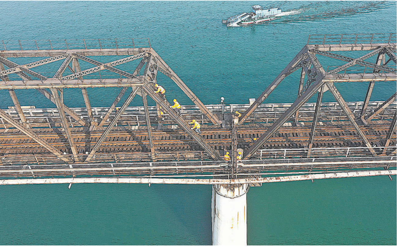
柳州工务段柳州路桥检查工区工人检修柳江铁桥钢梁顶部(1月14日摄)。连日来,中国铁路南宁局集团有限公司柳州工务段的守桥工人对柳江铁桥实施“微创修复手术”,提升铁桥线路质量,夯实安全基础。 新华社记者 张爱林摄
