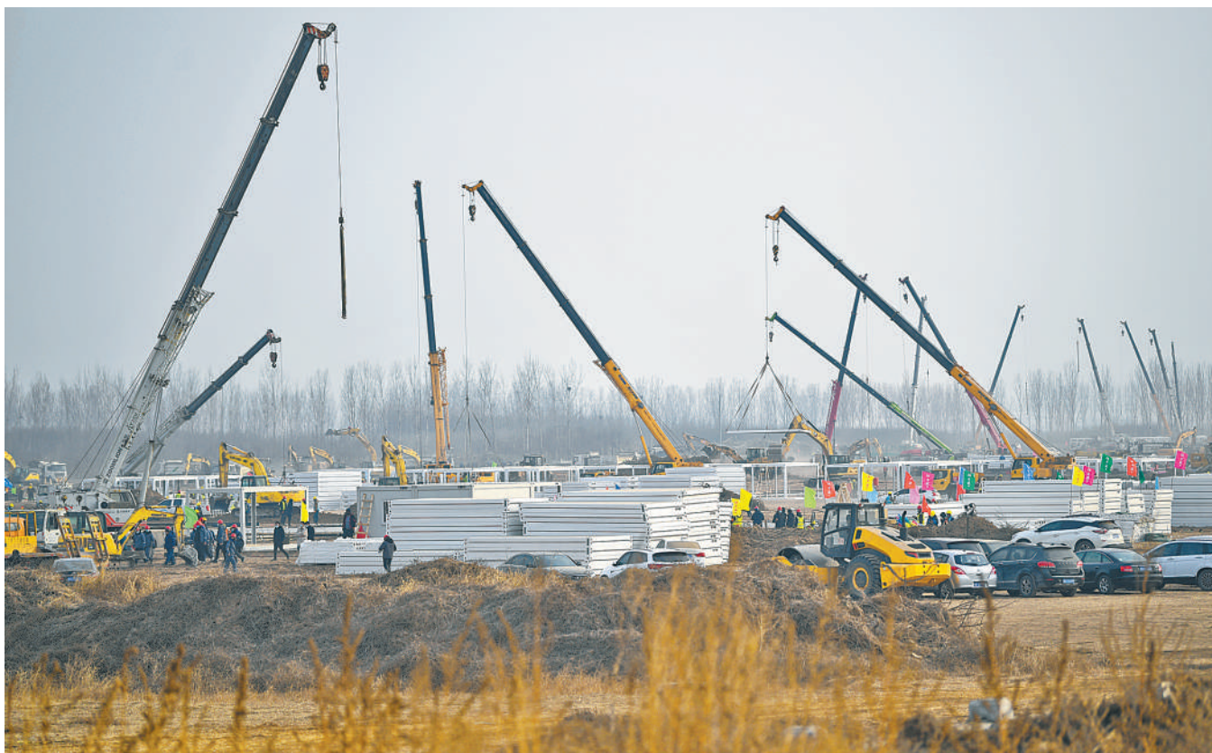
1月14日，石家庄市集中隔离点建设工地一派繁忙景象。
