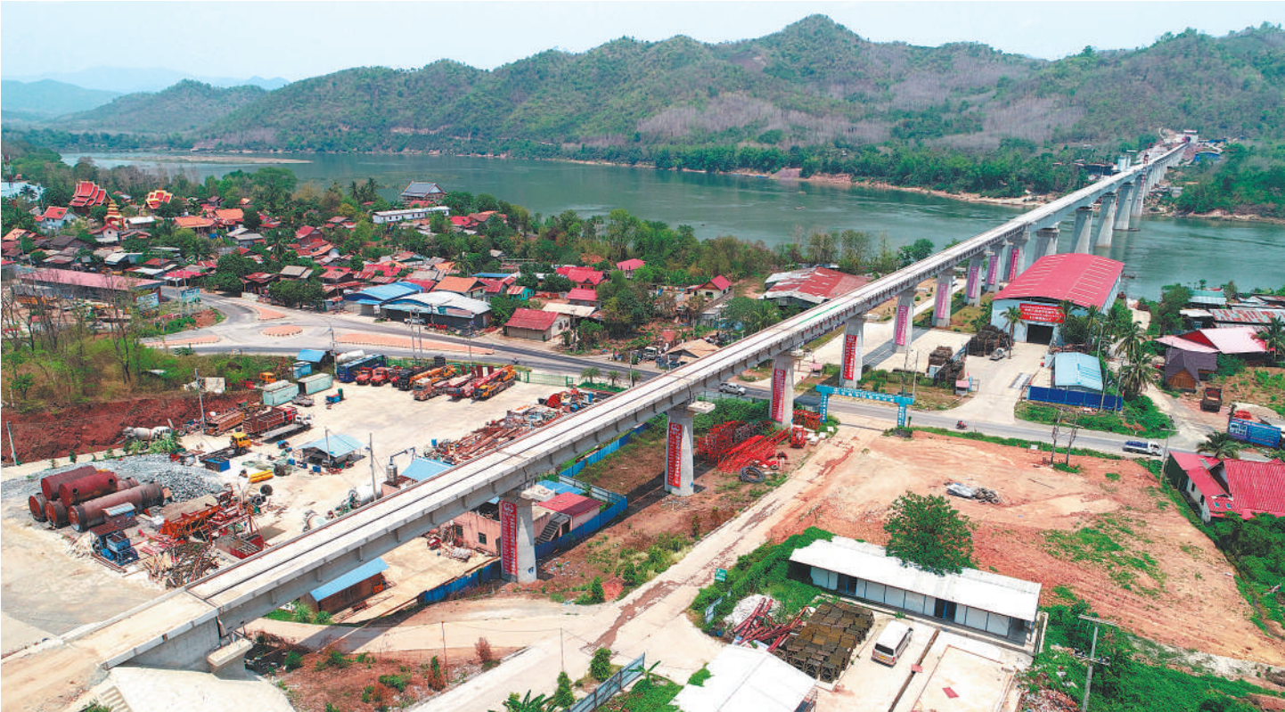
日前,中老铁路琅勃拉邦湄公河特大桥架设完成。中老铁路是中国“一带一路”倡议与老挝“变陆锁国为陆联国”战略对接项目,北起中老边境口岸磨丁,南至老挝首都万象,全长414公里。图为老挝中老铁路琅勃拉邦湄公河特大桥T梁架设现场。(中铁八局供图)
