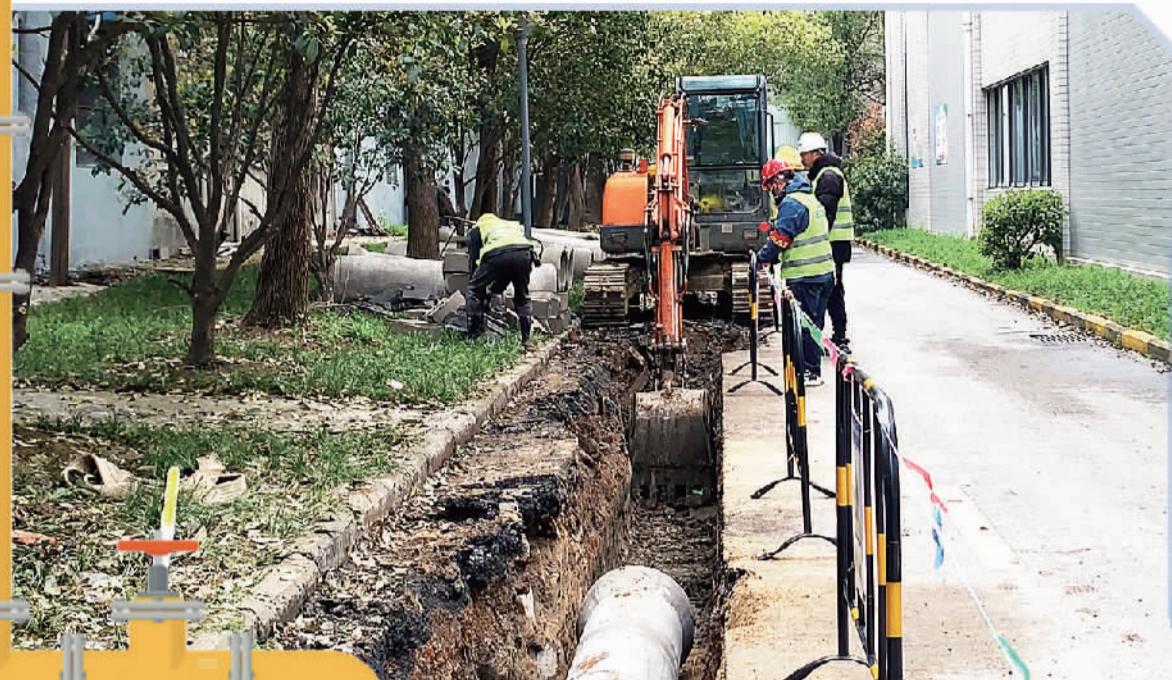
施工人员正在改造合肥市肥西县肥西宾馆附近的排水管道，以提升城市防洪能力。 本报记者 梁睿摄
