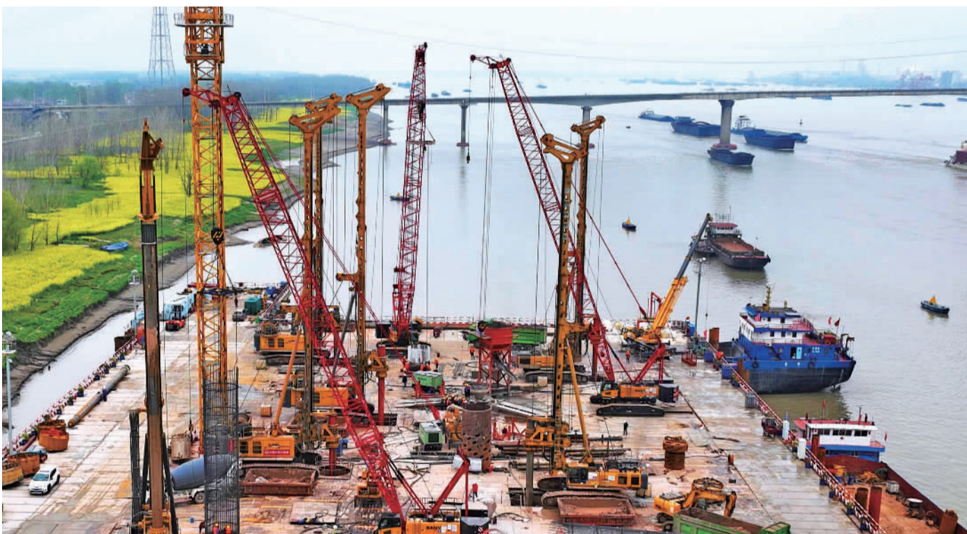
3月18日,中铁大桥局施工人员在G3铜陵长江公铁大桥3号主墩工地上进行施工。进入3月份,项目部优化施工工艺,钻孔桩施工进度已经过半。过任宁摄(中经视觉)
