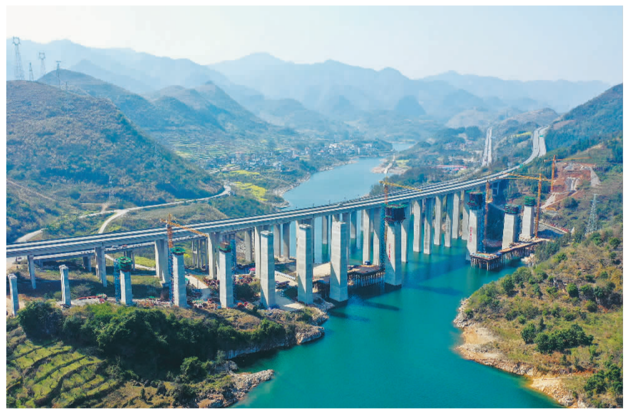
贵州省黔西南布依族苗族自治州兴义市清水河镇盘兴高铁纳怀河特大桥施工现场一派繁忙。盘兴高铁北起沪昆高铁盘州站，止于兴义南站，是贵州省城际铁路规划重要组成路段。刘朝富摄(中经视觉)
