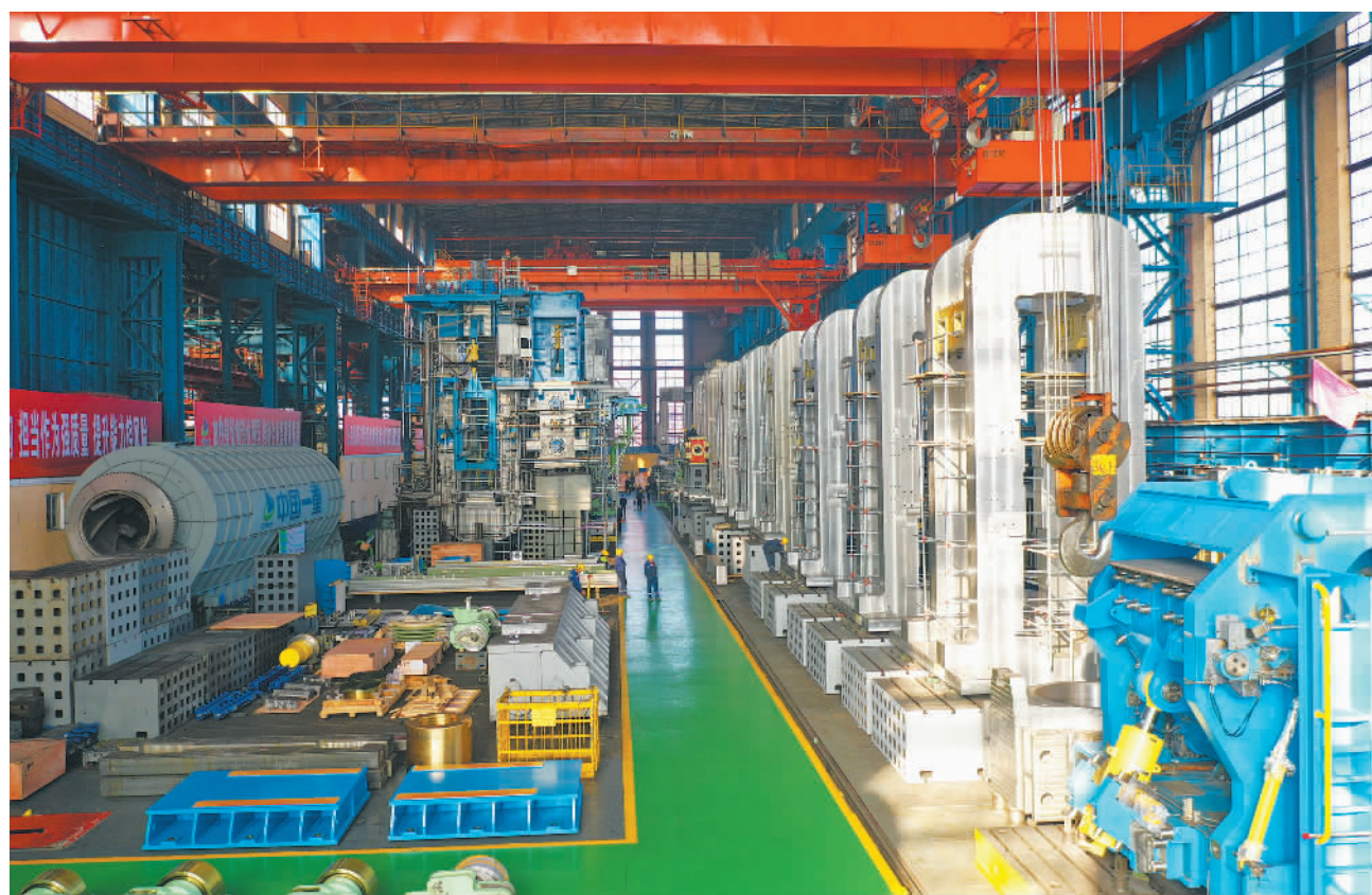
中国一重重型装备制造厂百米装配线。
