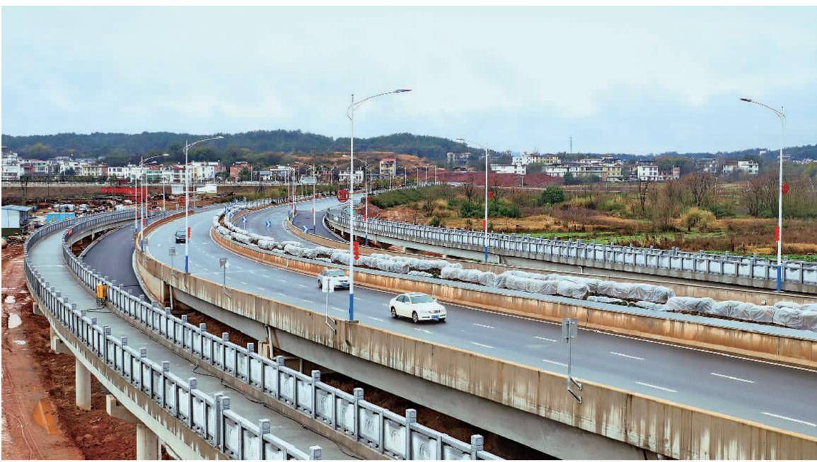
2月17日,车辆行驶在江西省赣州市庄稼大桥上。当日,该桥两厢连接线工程全线竣工。该工程位于赣州市南康区唐江镇庄稼大桥旁,为满足非机动车过江需求,在庄稼大桥起点和终点修建匝道连接原有桥面过江非机动车道,双向四股匝道总长1212米,将有效缓解通行压力。
