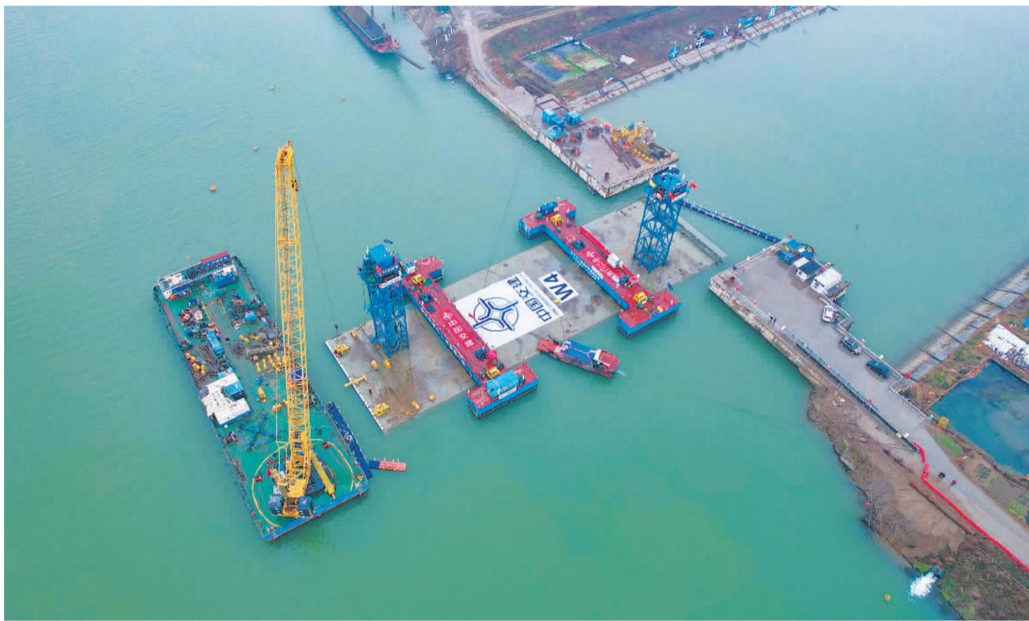
2月17日,由中交二航局参与投资建设的湖北省襄阳市东西轴线鱼梁洲过江隧道最后一节沉管安装完成。该过江隧道为国内整体规模最大的内河沉管隧道,华中地区首条内河沉管隧道,全长5.4公里,其建设为沉管隧道建设全产业链国产化发展提供了重要的技术借鉴和经验积累。 许 豹 摄 (中经视觉)
