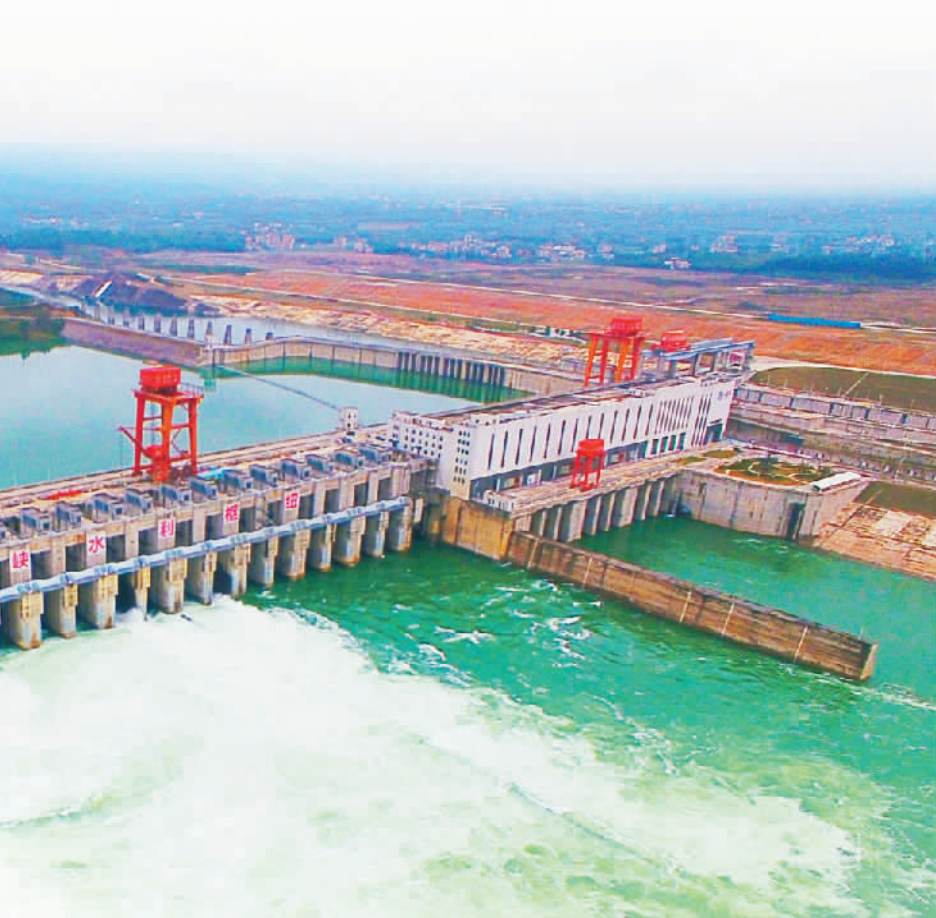
2月13日,水利部启动珠江流域压咸补淡应急补水调度。图为广西大藤峡水利枢纽开闸放水。 梁莹妍摄
