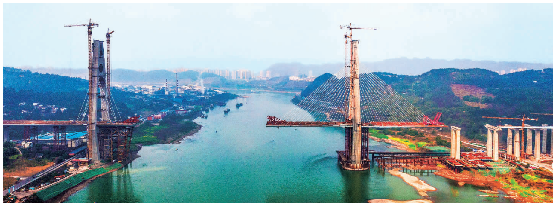
2月11日,四川宜宾市临港高铁两用长江大桥正架梁吊装,加快建设进度。该大桥全长1742.1米,是时速350公里自宜高铁的控制性工程。项目预计今年完成主体工程,明年建成通车。 易程程摄(中经视觉)
