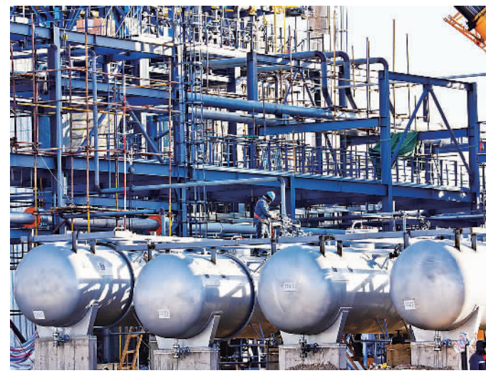
近日，甘肃张掖LNG(液化天然气)储备中心项目建设工地现场，建设者正在检测储气罐的平衡。据悉，张掖LNG储备中心是甘肃省规划建设6个天然气储气设施项目之一。
