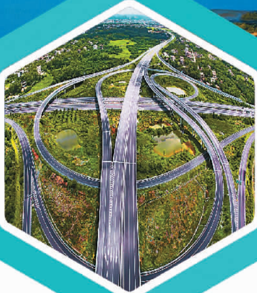
大昌口枢纽互通立交桥
