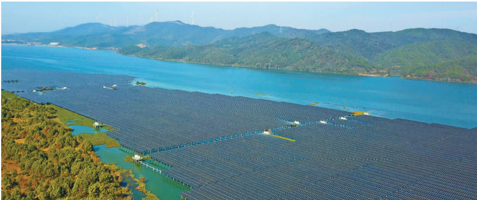
12月3日，江西省吉水县水田乡光伏电站整齐划一的光伏板熠熠生辉，与对面的风电机组隔江相望。水田乡光伏电站一期占地800亩，投资2.3亿元，自10月份开始试运行，截至目前最大发电量29万千瓦时，整个项目年上网电量可达5493万千瓦时。
