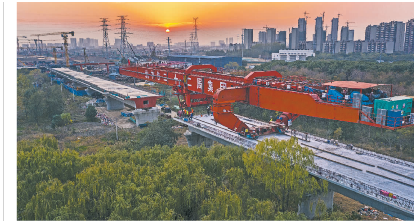
11月18日,由中铁二十二局参建的南沿江城际铁路江阴至张家港段新型箱梁架设全部完工,标志着国内首条大规模采用40米千吨箱梁的高铁建设取得重要进展。40米千吨箱梁跨度更大、吨位更重,可以减少更多的桥墩连接点,让高铁列车达到更高运行速度。图为千吨级穿梁式架桥机进行江阴至张家港段最后一孔40米千吨箱梁架设作业。侯钦佩摄(中经视觉)
