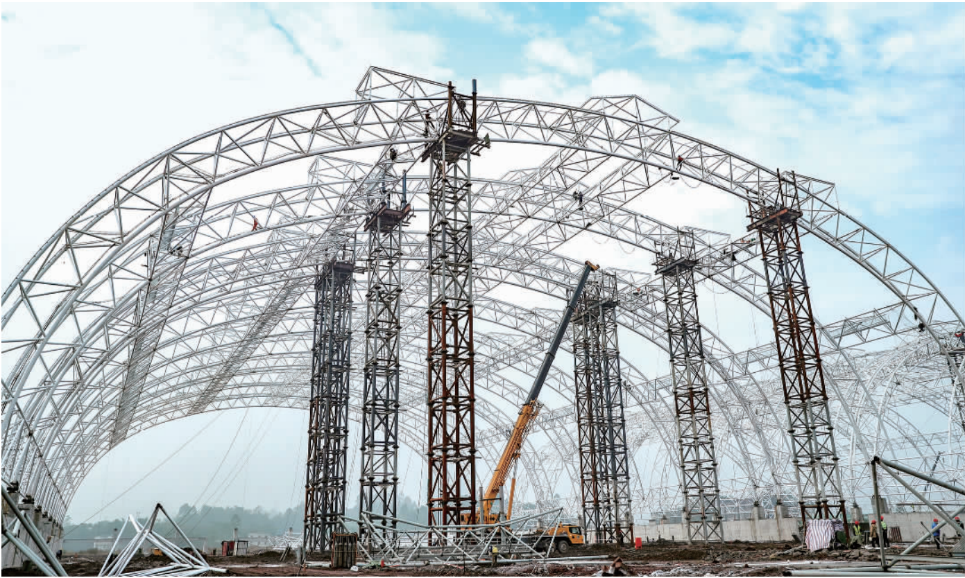
11月12日，四川省广安莹莹物流园区国家级煤炭储备基地的建设者，正在搭建储煤棚桁架。
