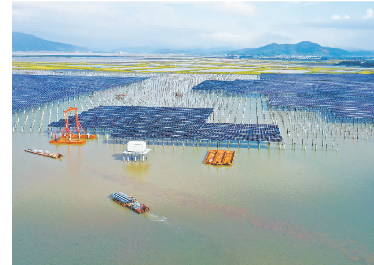
10月10日,浙江省玉环市清港镇苔山塘1800亩海涂100兆瓦“渔光互补”光伏发电项目工程加紧施工。玉环市结合海岛地区土地少、资源少等实际情况,在开展光伏发电项目建设的同时,有效利用地面资源,形成“棚上发电、棚下养鱼”的综合利用新模式,可实现年均发电量约1.4亿千瓦时,有效促进地方经济绿色发展。
