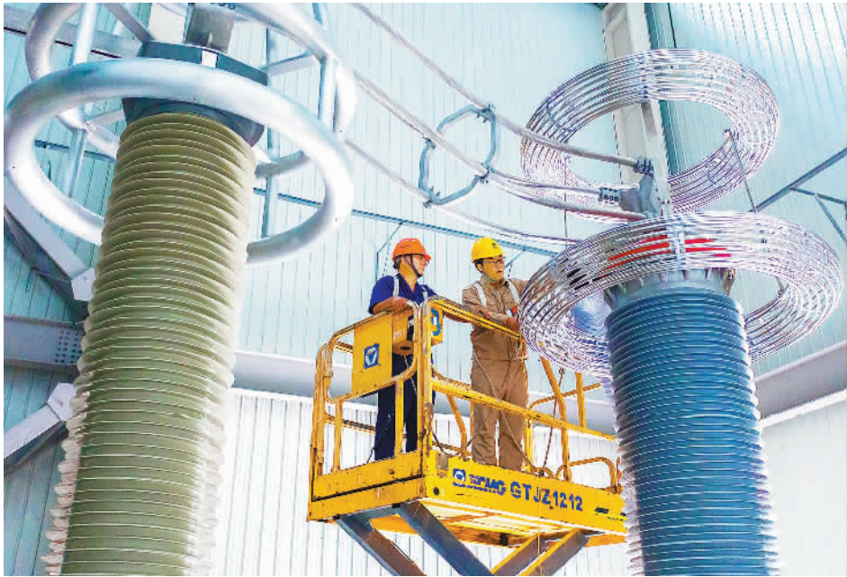
9月11日,亚洲首条±400千伏直流海缆验收试验在江苏如东顺利完成,标志着“三峡—中广核”如东±400千伏柔性直流海上风电项目具备了送电投运条件。图为工作人员在进行阀厅加压线搭接。 汤德宏摄(中经视觉)
