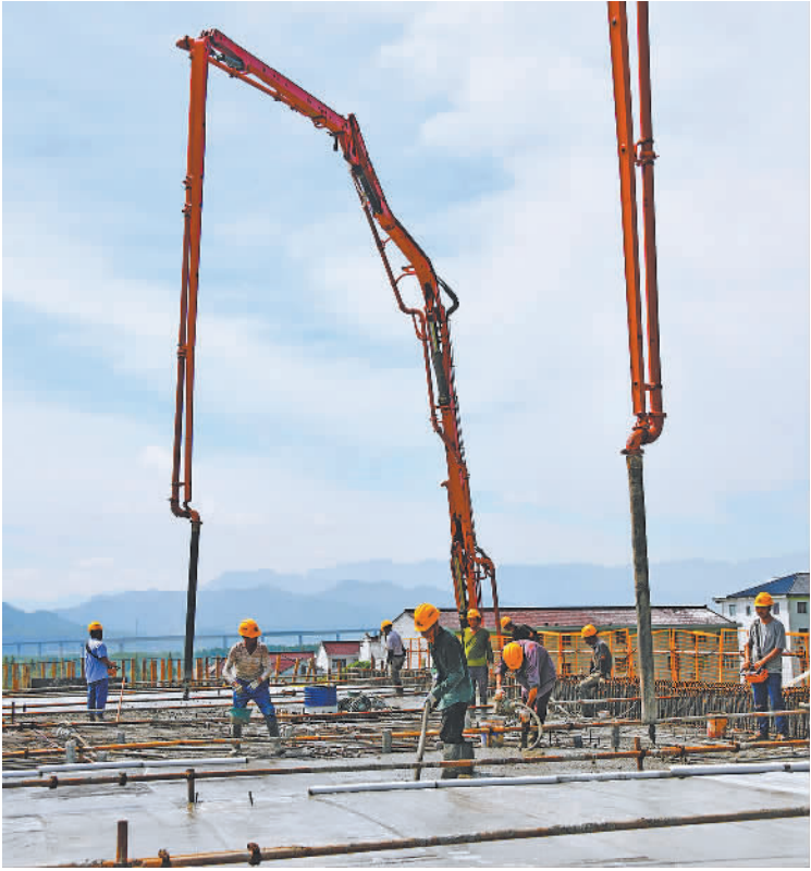
9月5日，在杭温铁路浙江台州市仙居高架站项目现场，中铁上海局建设者正在紧张施工。当日，杭温铁路台州市仙居高架站右线0-4#墩道岔连续梁工程顺利浇筑完成，标志着该高架站正式进入道岔连续梁施工阶段。
