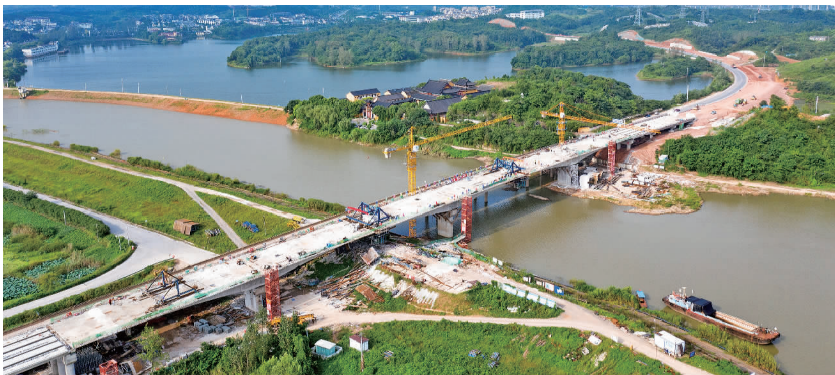
8月28日，在安徽省铜陵、池州两市交界的G236青通河大桥改建工程左幅主桥合龙作业现场，施工人员进行合龙施工。 詹俊摄 (中经视觉)
