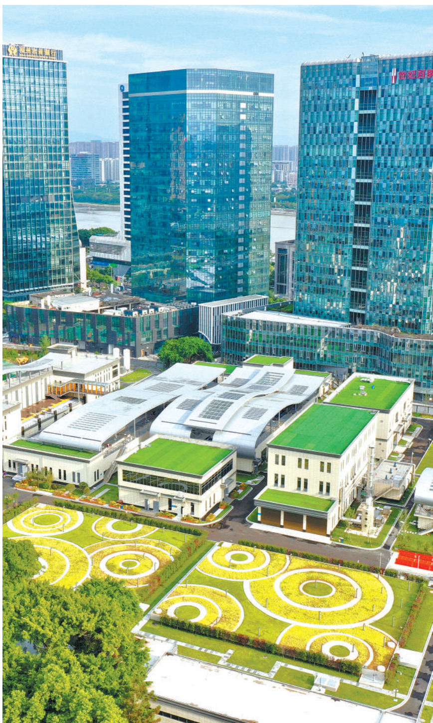
这是8月11日拍摄的升级改造后的福州市东南区水厂(无人机照片)。近日,由中铁上海工程局集团市政环保公司承建的福州市东南区水厂工艺改造项目顺利通过竣工验收,投入运营。该水厂采用进水端“预臭氧”投加,出水端增加“臭氧+生物活性炭”等深度处理工艺,大幅提升出厂水质及其稳定性,日供水量15万吨。新华社记者 姜克摄
