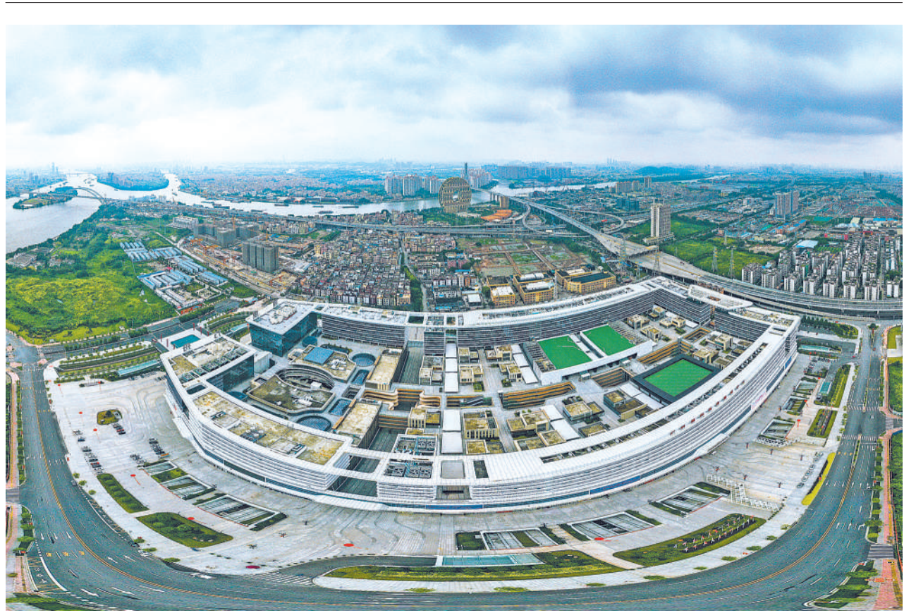
8月5日,广州国际医药港首期项目——“健康方舟”试营业中,该项目建筑面积90万平方米,投资逾100亿元,融合了“新展览、新医疗、新生活、大平台”四大领先业态。医药港将立足粤港澳大湾区、服务全国、面向全球,搭建粤港澳大湾区与世界健康产业交流合作的桥梁。
