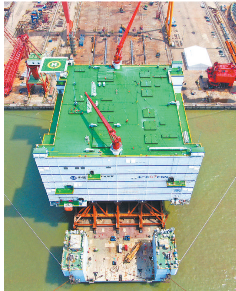
7月8日，三峡如东海上换流站发运仪式在江苏南通振华重装码头举行，该换流站将为我国进入深海、远海风电开发领域提供坚实装备技术支持。 许丛军摄(中经视觉)
