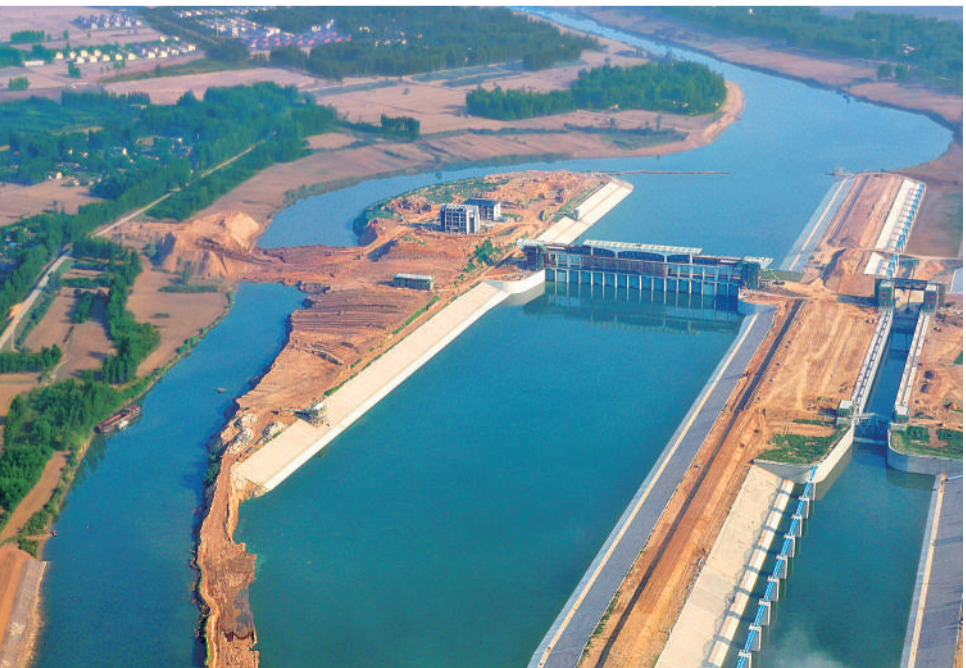
6月22日，俯瞰安徽省蒙城县的涡河蒙城枢纽工程，蔚为壮观。该工程于近日正式通水，不仅改善了涡河通航条件，提高了泄洪能力，还兼顾了保护生态的要求。 胡卫国摄(中经视觉)
