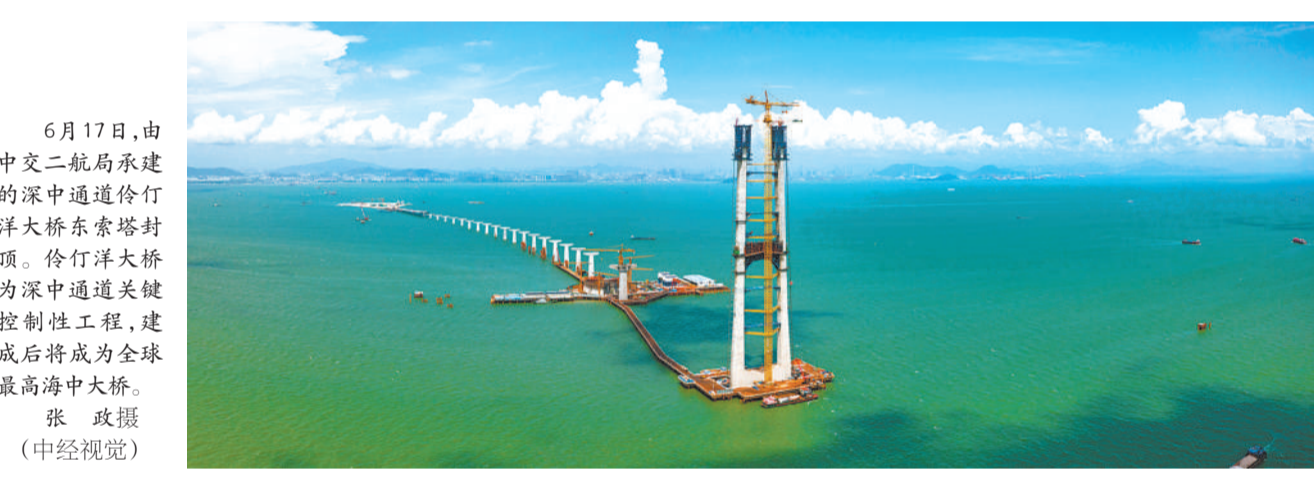
6月17日，由中交二航局承建的深中通道伶仃洋大桥东塔塔封门。伶仃洋大桥为深中通道关键控制性工程，建成后将成为全球最高海中大桥。
