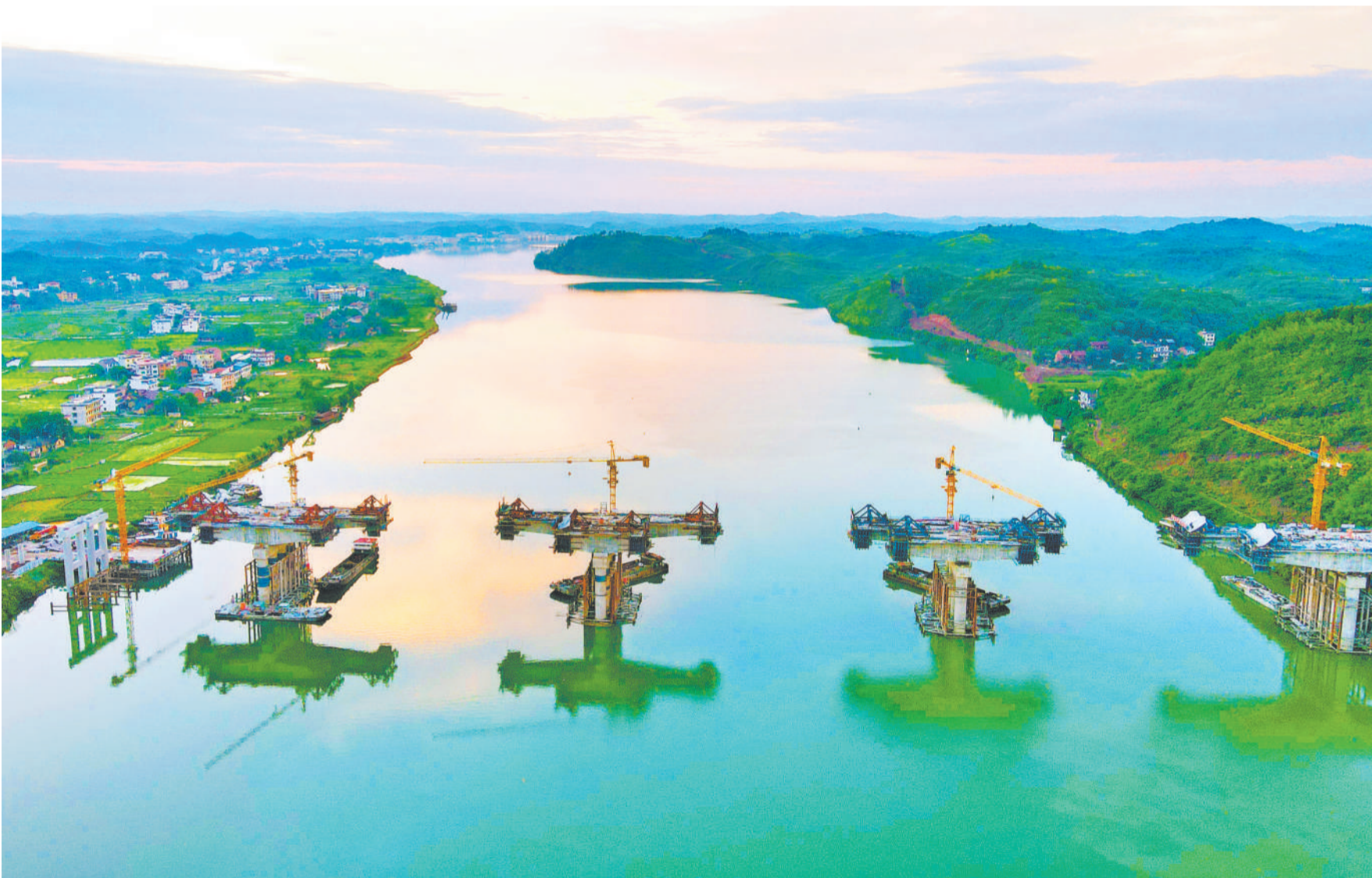
6月13日,横跨湘江的常祁高速公路石潭湘江特大桥正在加紧施工。常祁高速公路主线长约32公里,投资总概算33.29亿元,预计2021年底建成通车。常祁高速公路通车后,对加快湖南省“3+5”城市群东南环的形成、益娄衡高速与京港澳复线的对接,完善湖南省高速公路网、提升区域通行能力,加快与粤港澳大湾区的经济发展深度融合具有重要意义。
