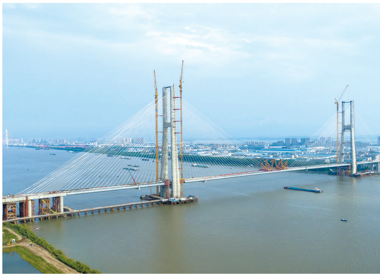
6月3日，国内首座交叉索斜拉桥——安九铁路鳊鱼洲长江大桥合龙。鳊鱼洲长江大桥北侧位于湖北黄梅县，南侧位于江西九江市，按照两线高铁及两线预留客货共线标准建设，高铁时速350公里，预留客货线时速200公里。丁凯摄(中经视觉)
