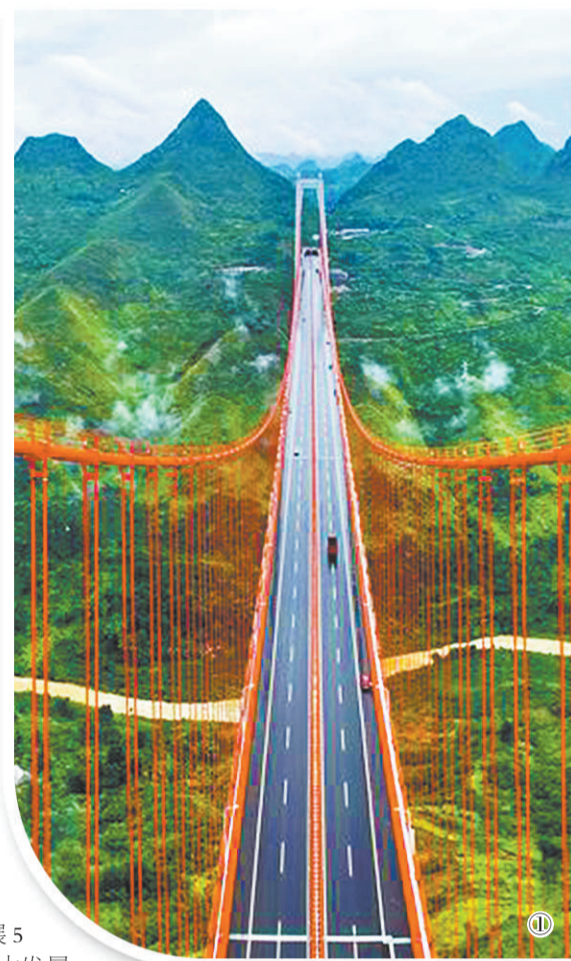
图① 位于安顺市的世界第一座千米级山区钢桁梁悬索桥——坝陵河特大桥。 陈恩光摄
