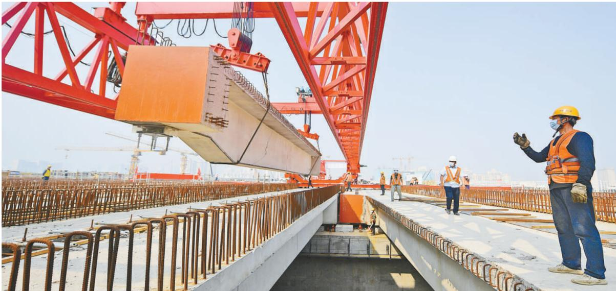
5月21日,随着最后一块钢筋混凝土筒梁的精准就位,北京丰台特大桥全桥贯通,实现高架车场与丰台站站房无缝衔接,为京广高铁引入丰台站打下基础。自此,丰台站即将进入全线铺轨阶段。
