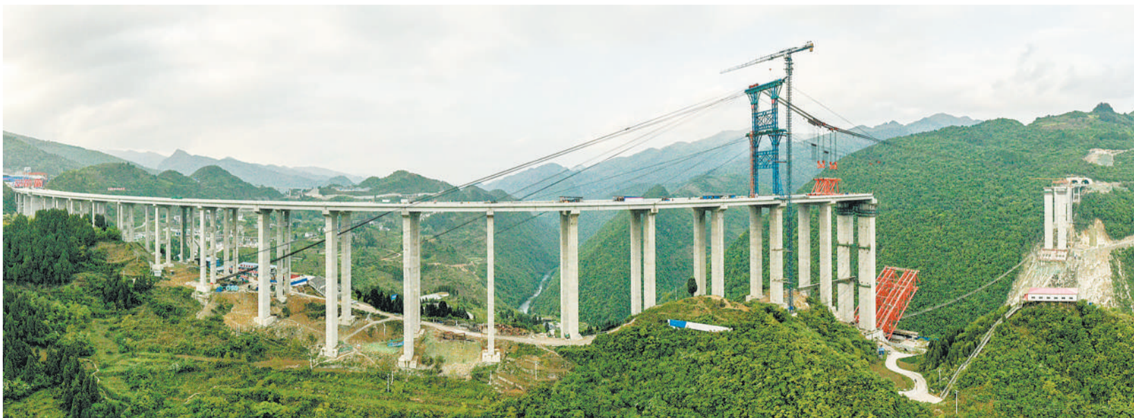
这是4月21日拍摄的贵州省仁遵高速公路大发渠特大桥施工现场。目前,仁(怀)遵(义)高速公路大发渠特大桥建设进展顺利,工程已进入主拱节段吊装阶段。
