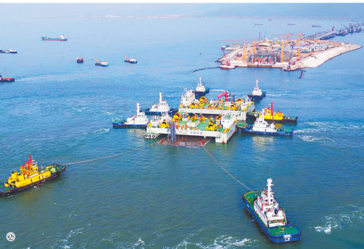
图① 港珠澳大桥。 喻剑摄 图② 沉管被拖运到海域进行沉放安装。（资料图片）
