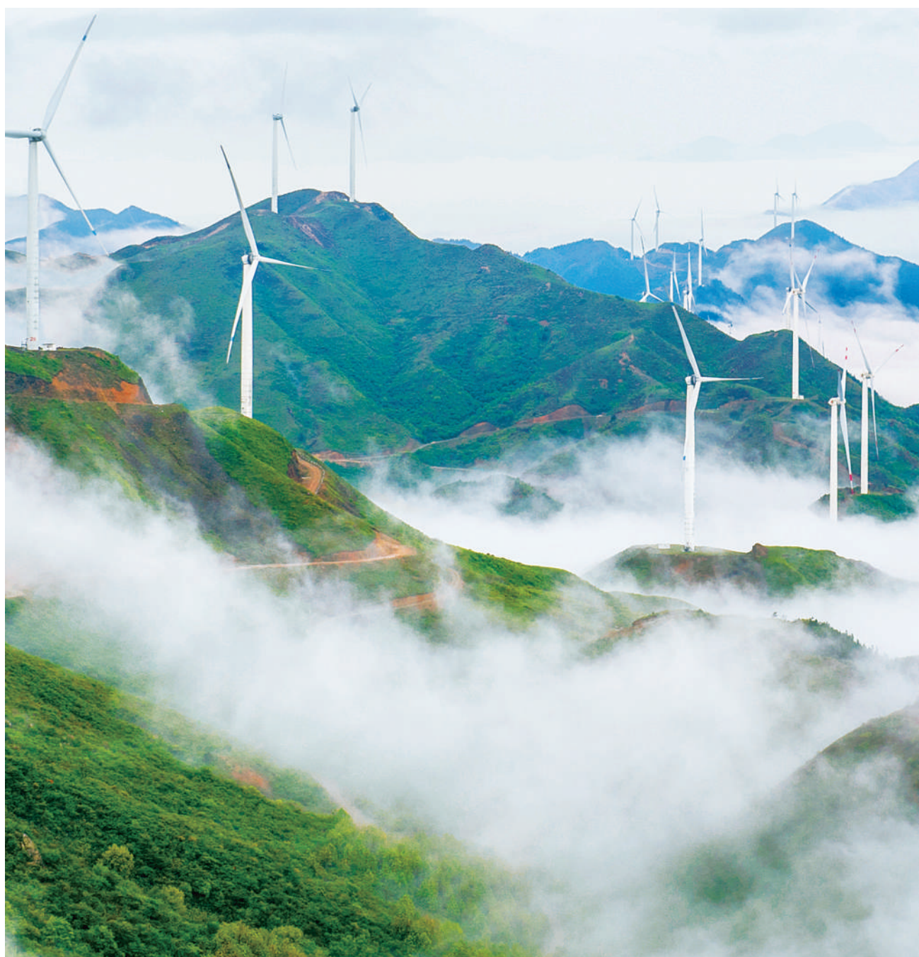
近日，庞大的风车群在江西省遂川县禾源镇洞溪村的筑峰顶转动，云雾缭绕，蔚为壮观。近年来，当地充分利用山区风能资源丰富的优势，大力推动风电产业发展，探索经济转型升级新路，形成了集风能开发、观光旅游、环保示范于一体的风电长廊。李书哲摄(中经视觉)
