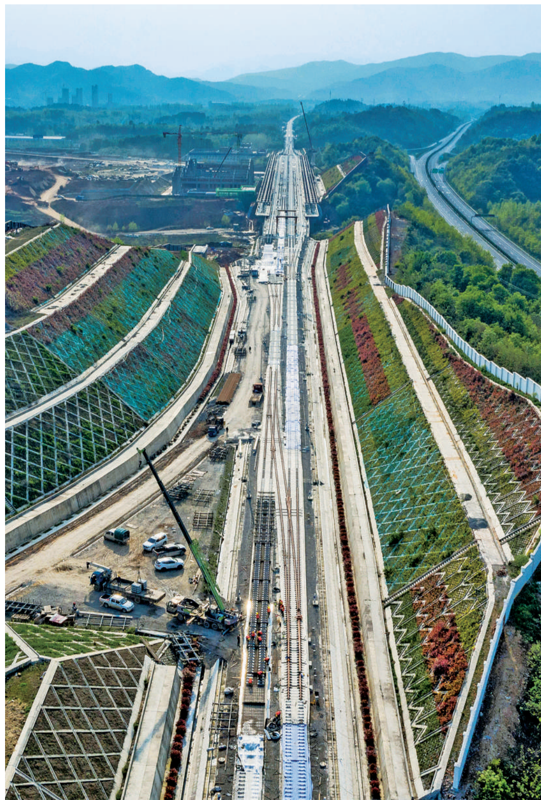
这是4月12日在郑万高铁南漳站拍摄的中铁十一局无砟轨道施工现场(无人机照片)。目前,经过中铁十一局等参建单位建设者艰苦奋战,郑万高铁湖北段进入无砟轨道施工冲刺。郑万高铁全长818公里,设计时速350公里,起于郑州南站,经过湖北、重庆,终到万州北站。 新华社记者 杜华举摄
