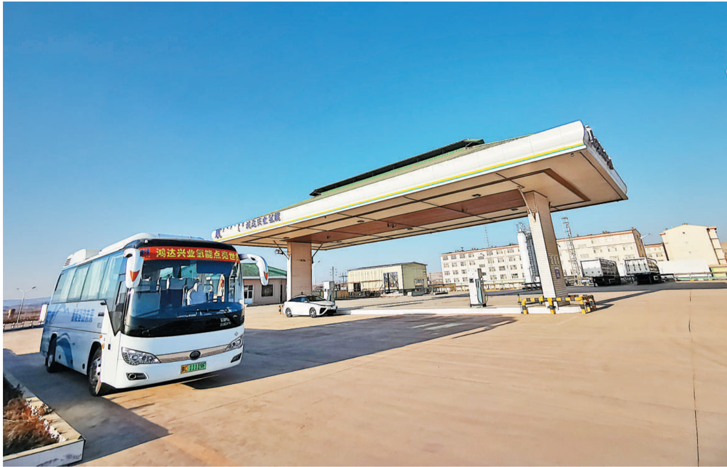
图为内蒙古第一座日加注能力为600公斤、可提供三种压力等级加注的加氢站。
