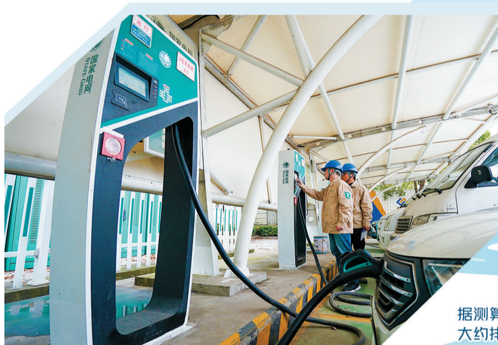
上图 国网苏州供电公司的工作人员在苏州综合保税区东充电站内巡检。截至2020年11月底，接入苏州市新能源汽车及充电设施监测平台的充电设施运营商家达到23家、充电站(点)964座。新华社记者 李博摄
