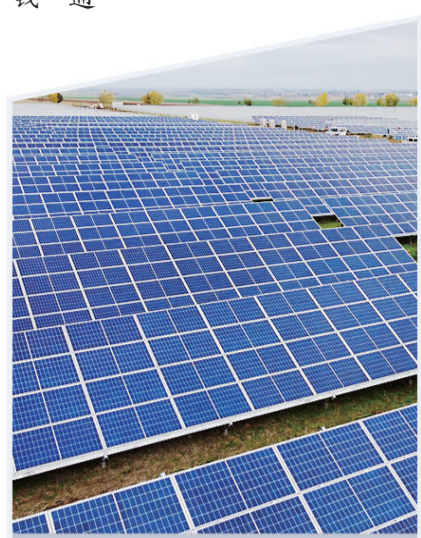
正在建设中的匈牙利波什堡光伏电站。(2020年10月30日摄)(新华社发)
