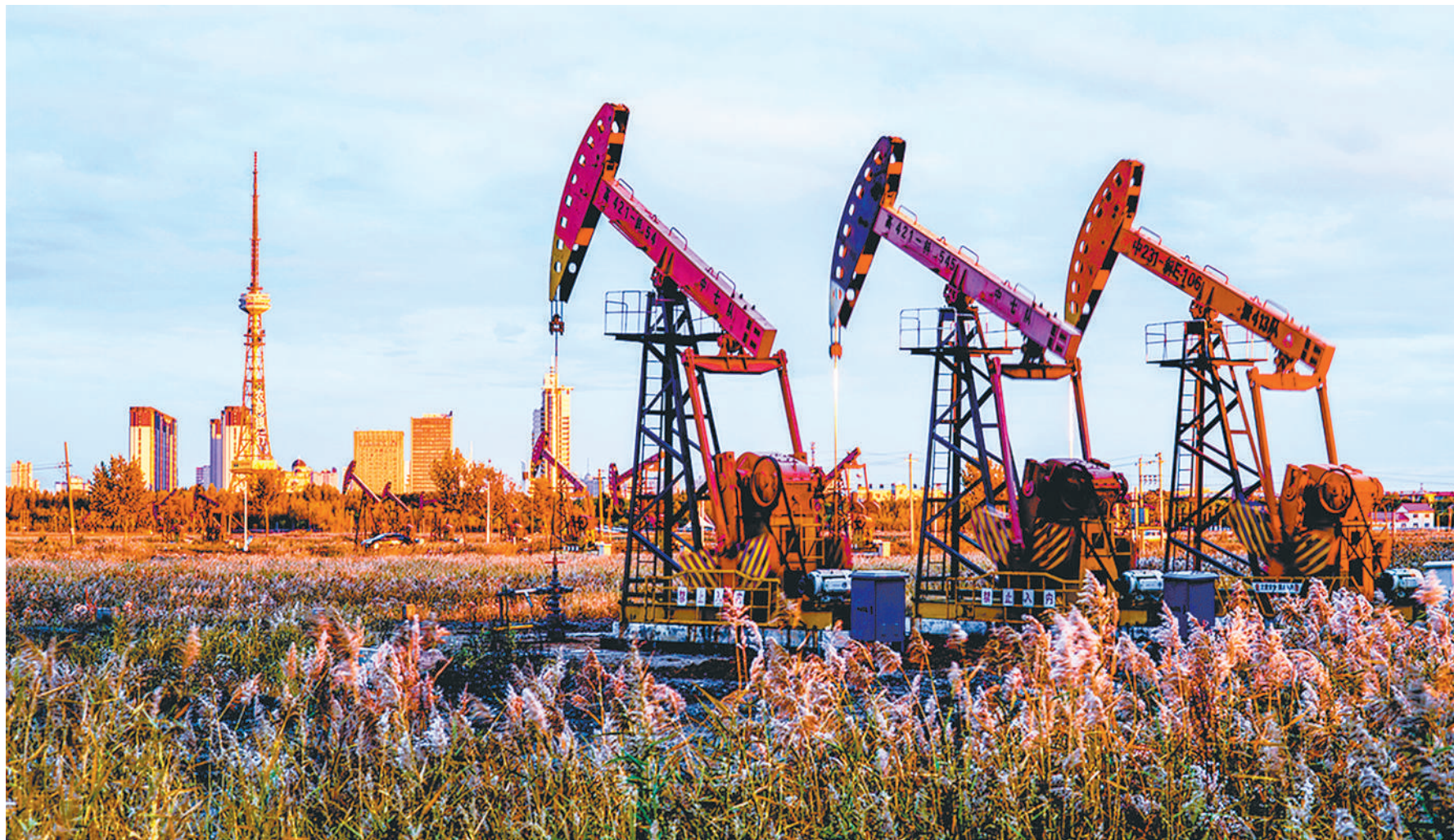
图为黑龙江大庆市萨尔图区大庆油田抽油机工作现场。
