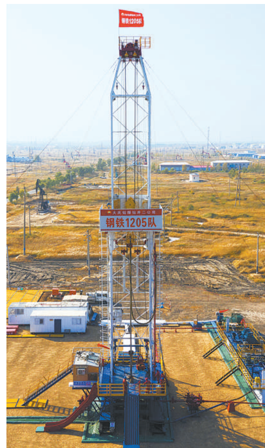
大庆油田1205钻井队的钻井井架(2019年9月28日无人机拍摄)。
