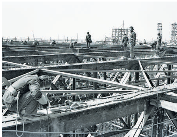
人民大会堂建设施工现场。（北京建院供图）
