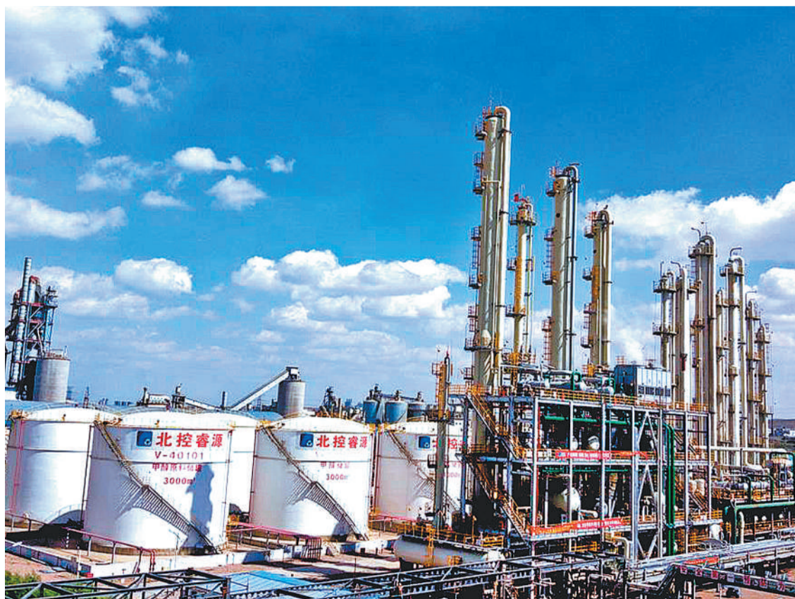
国内领先的宁夏宁东能源化工基地精细煤化工项目。
