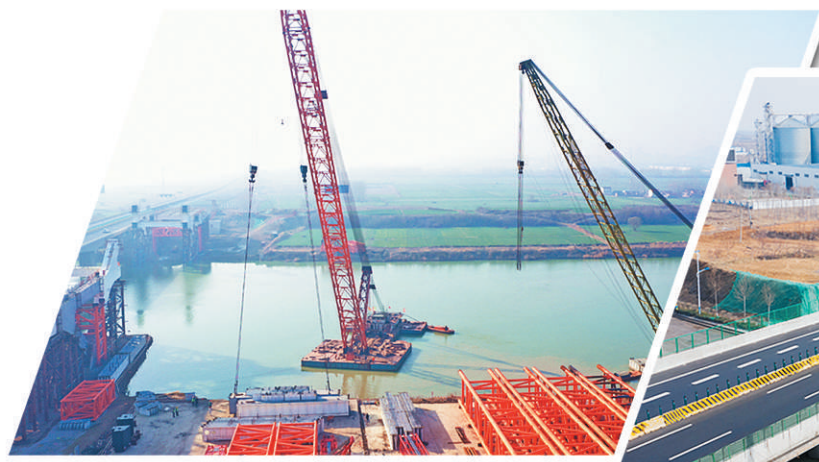
京台高速泰安至枣庄段改扩建项目京杭运河特大桥钢横梁吊装施工
