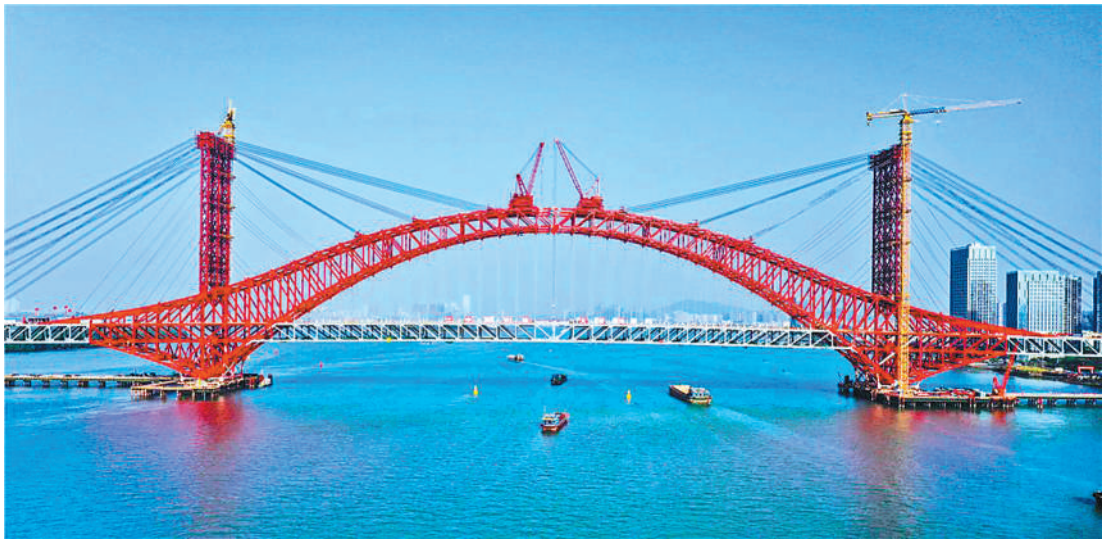
2月3日，广州南沙明珠湾大桥主桥合龙，创下“三主桁钢桁拱双层桥”最大跨度世界纪录。
