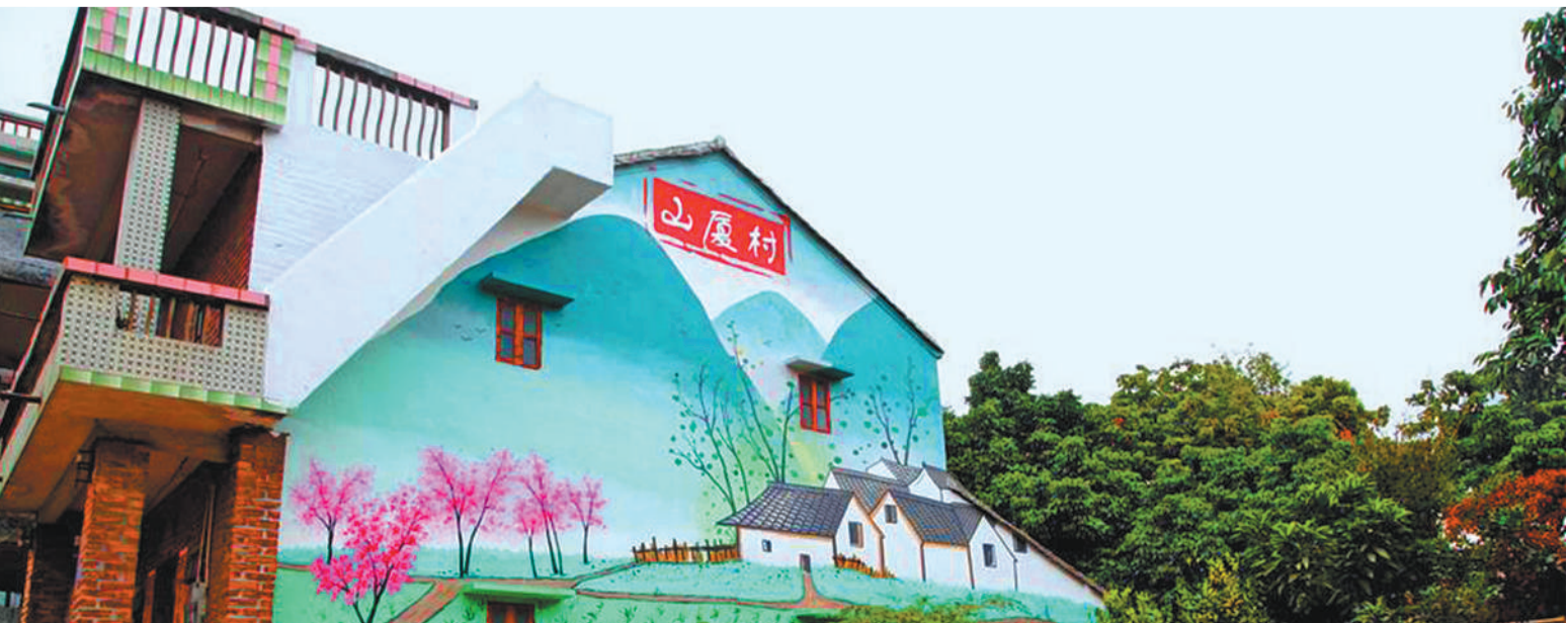
横沥镇山厦村的村民休憩公园。
