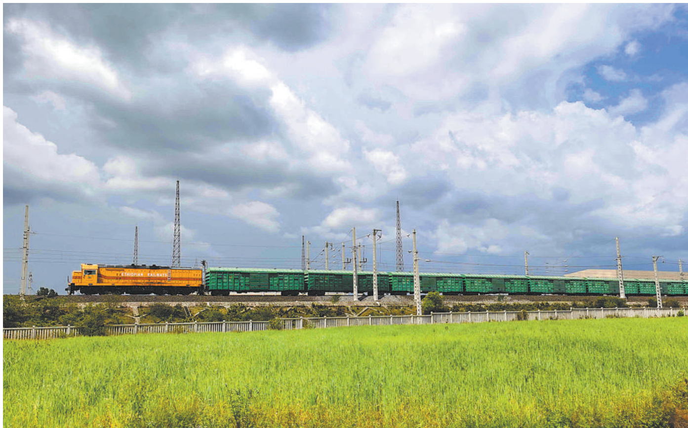
亚吉铁路是非洲第一条电气化跨国铁路,全部采用中国标准和中国装备建设而成。图为从吉布提进口的物资通过亚吉铁路到达埃塞俄比亚英多得货场。(新华社发)
