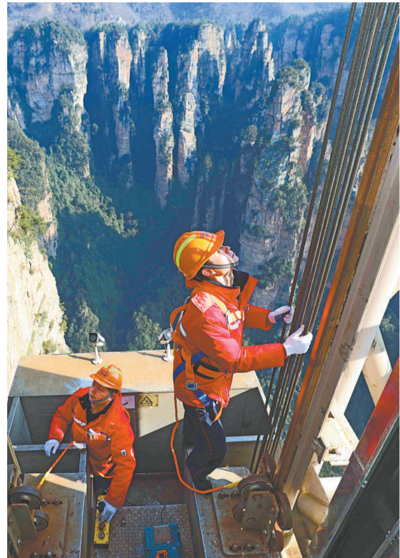
1月1日，湖南省张家界市武陵源景区，工作人员在悬崖钢架上检查百龙天梯运行情况，确保设备正常运转。吴勇兵摄(中经视觉)
