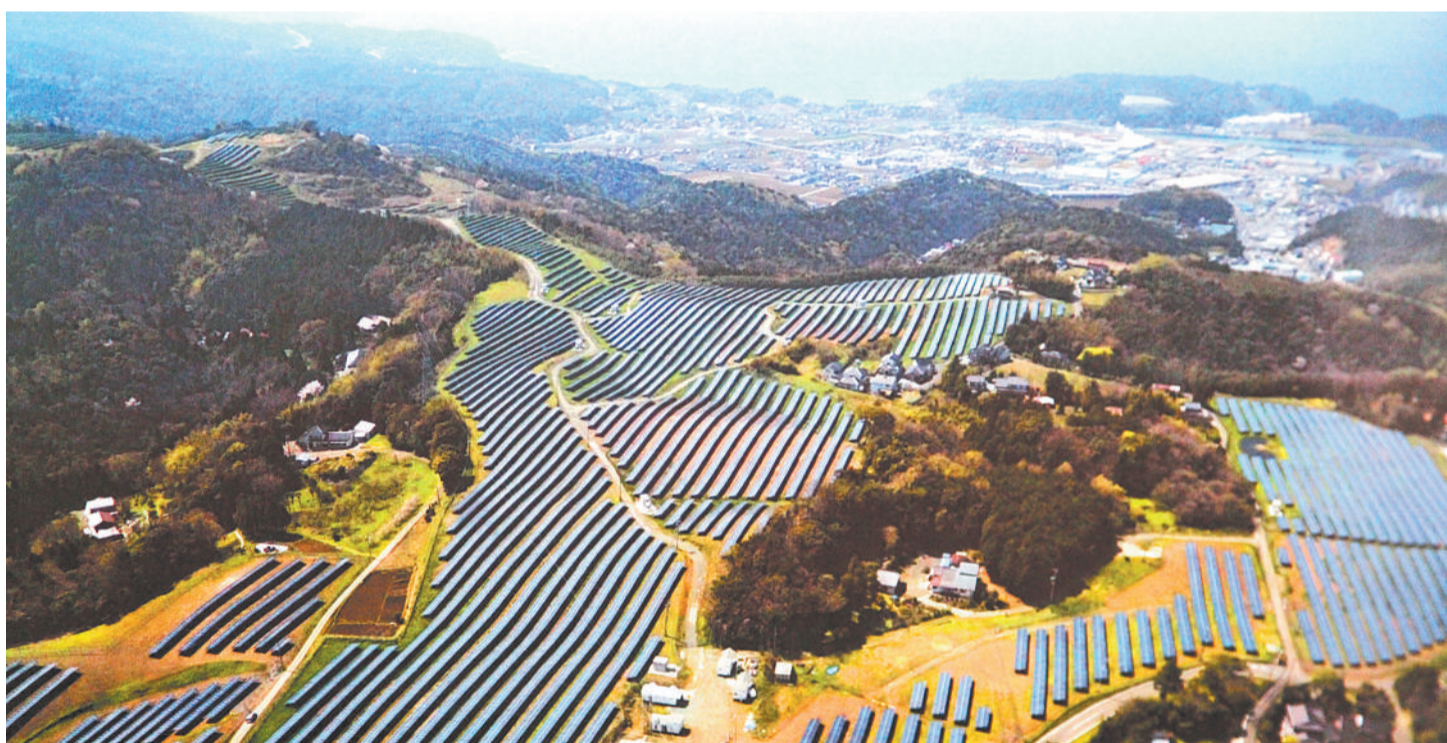
图为位于日本大分县的光伏发电站。
