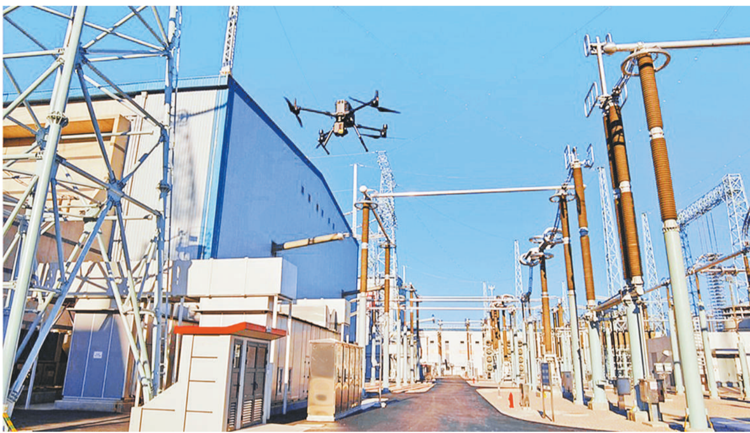
12月1日,大疆无人机在南方电网超高压公司昆明局昆北换流站自动飞行巡检。
